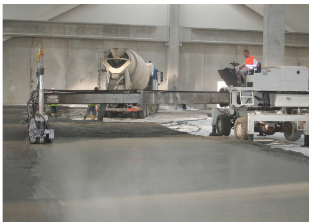
Vibrostesura al laser screed
