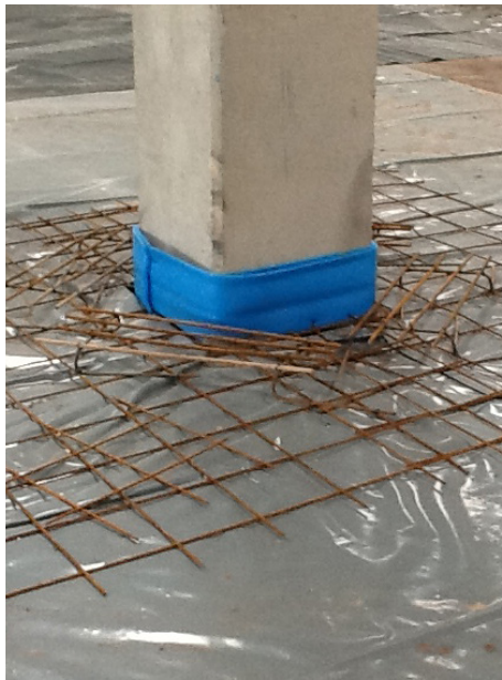
Isolamento strutturale Spessore - 5/10 mm
