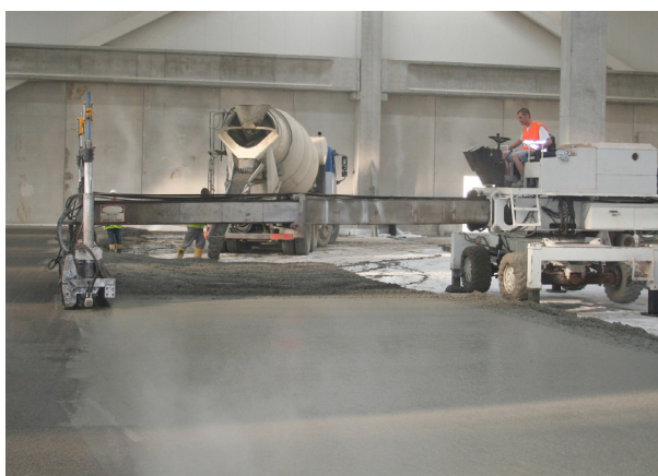
Vibroépandage laser screed
